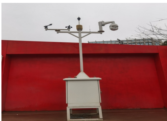
图 16 扬尘监控设备
