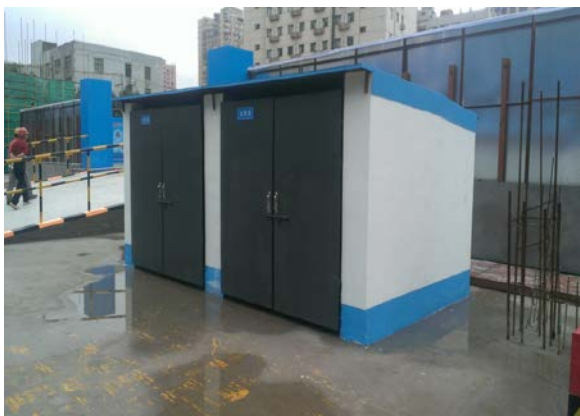
图 22 建筑垃圾堆放
