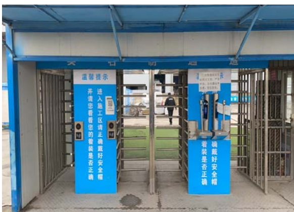
图 8 工地副门设置
