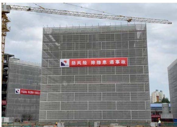
图 14 承插型盘扣式钢管脚手架
