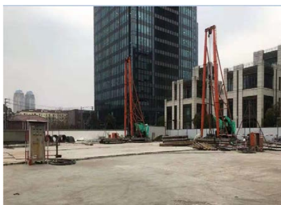
图 17 钻孔灌注桩施工场地硬化
