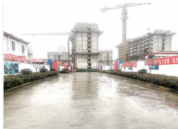
图 15 现场道路场地硬化
