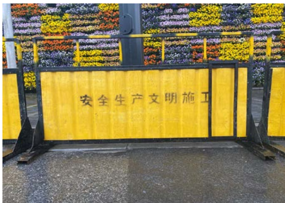
图 5 市政工程定型化施工路拦
